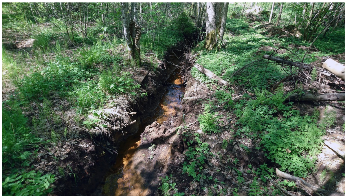
Grävt dike i sumpskogen i nordöst. Foto Leif Andersson.
