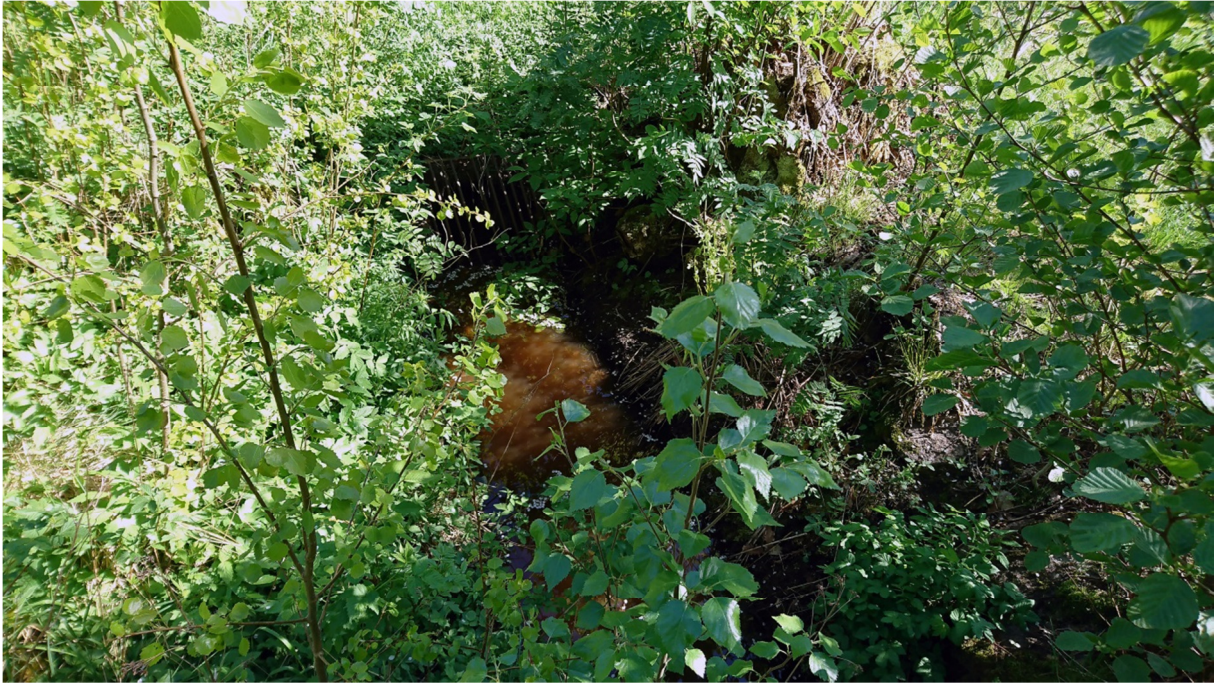
De grävda dikena i lövsumpskogen i nordöst leds vidare in i en kulvert vid villabebyggelsen. Foto Leif Andersson.
